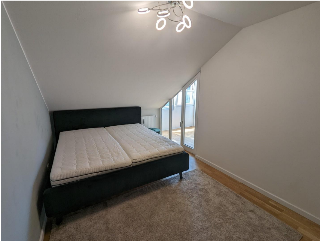
Schlafzimmer vor Fenstereinbau
