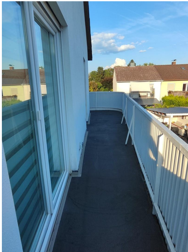
Balkon im OG
