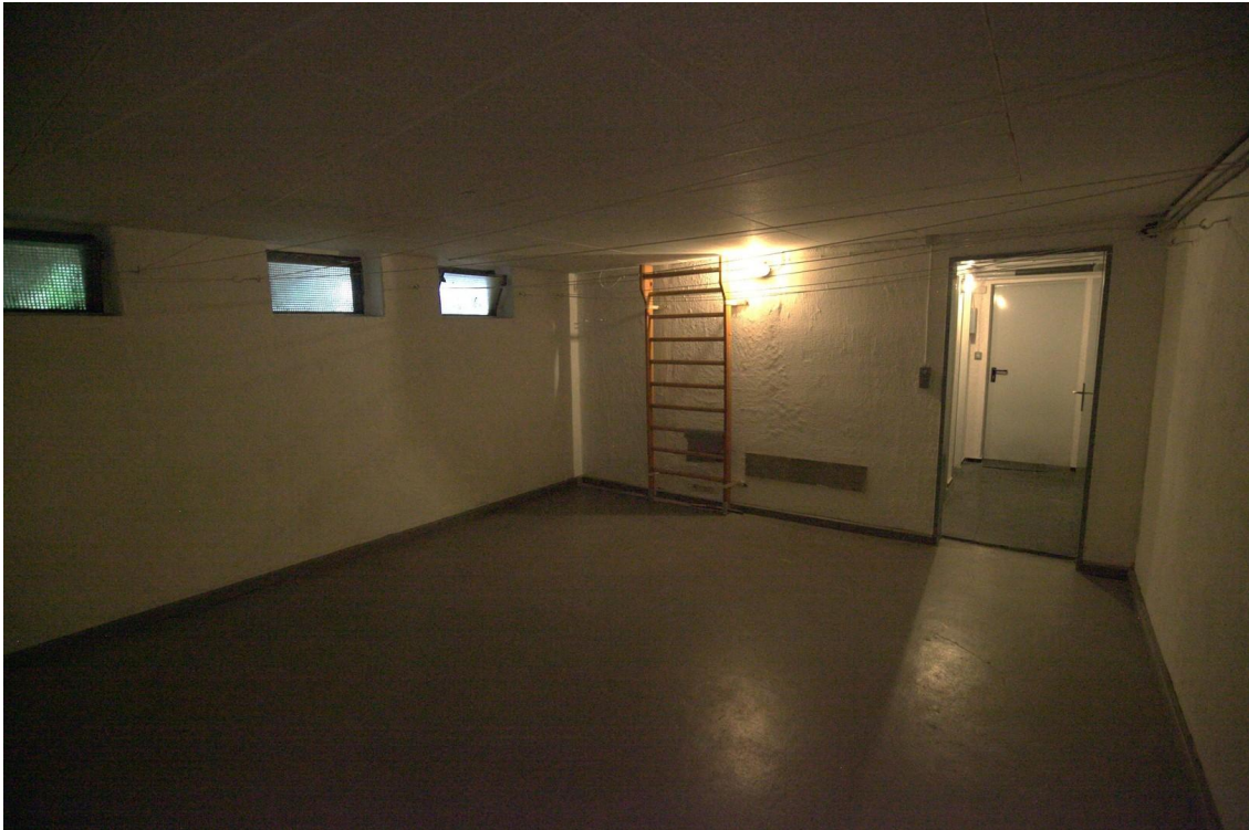
Trockenraum im Keller
