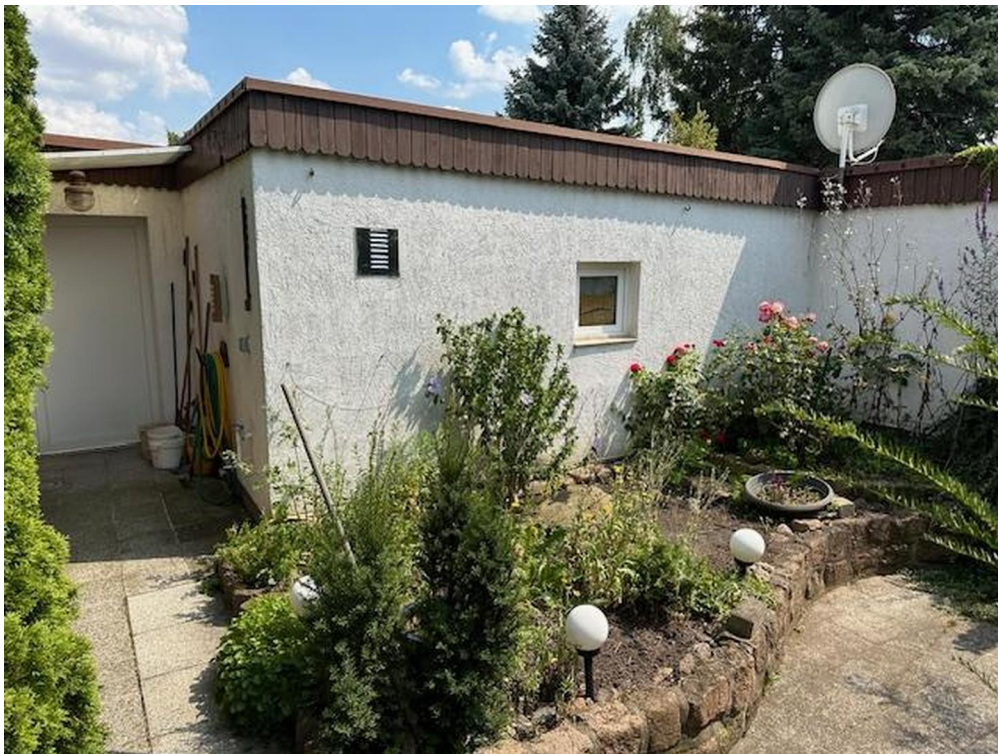
Zugang Garage vom Garten
