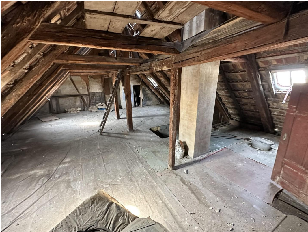
Dachspitz nicht ausgebaut
