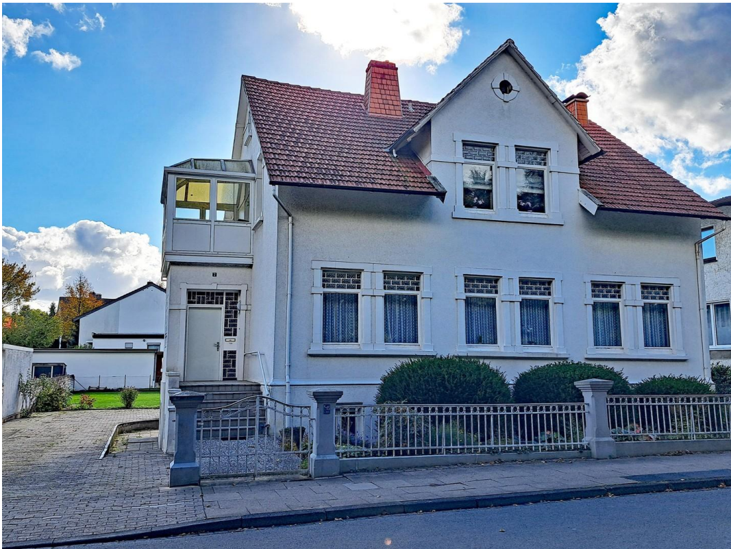
Ansicht mit Grundstückzufahrt
