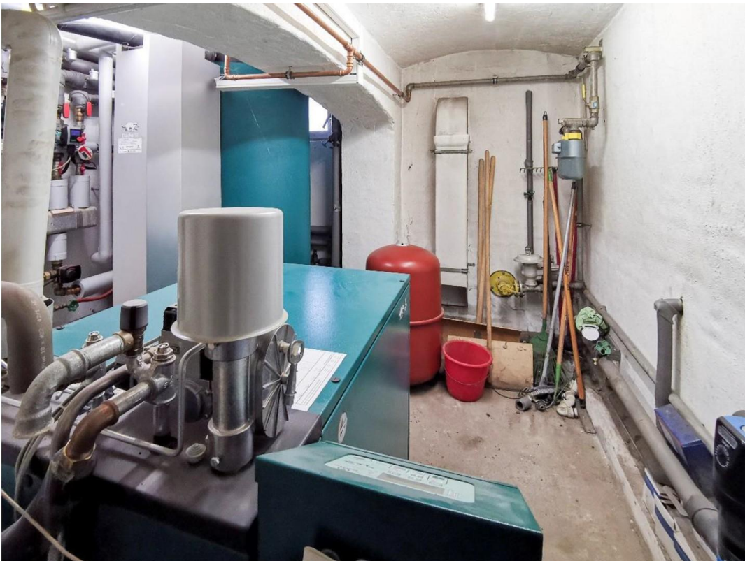
Heizungsanlage BHKW
