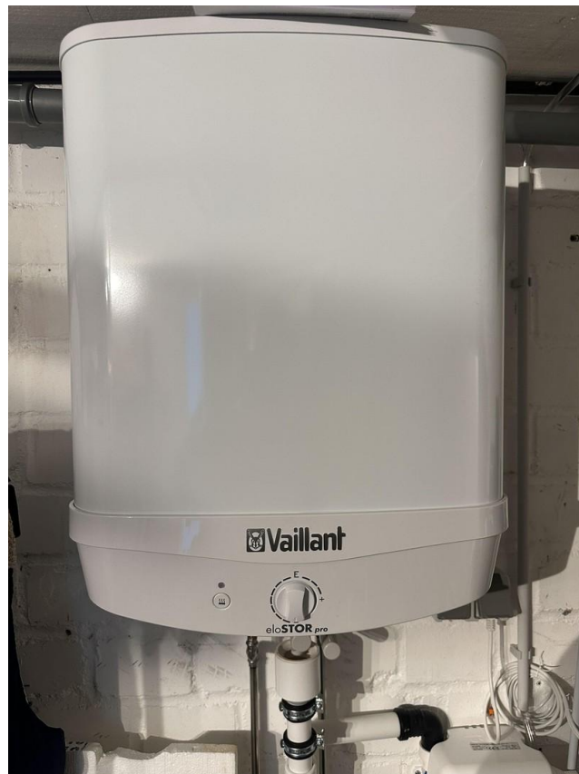
Warmwassertherme
