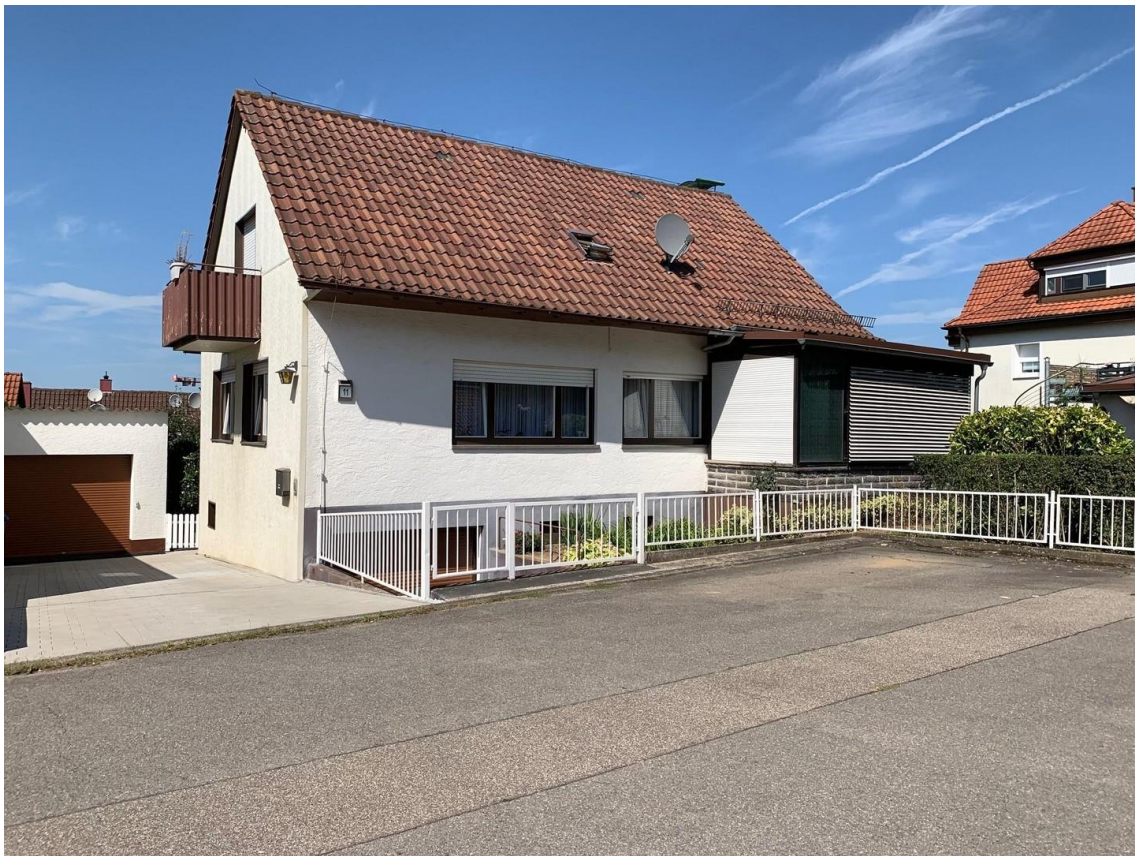
Ansicht von der Strasse 2
