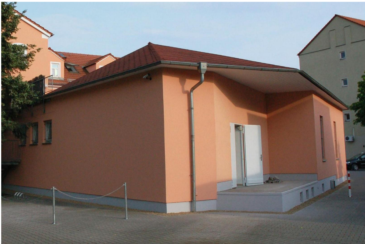
gr Rampe, LKW Anfahrt
