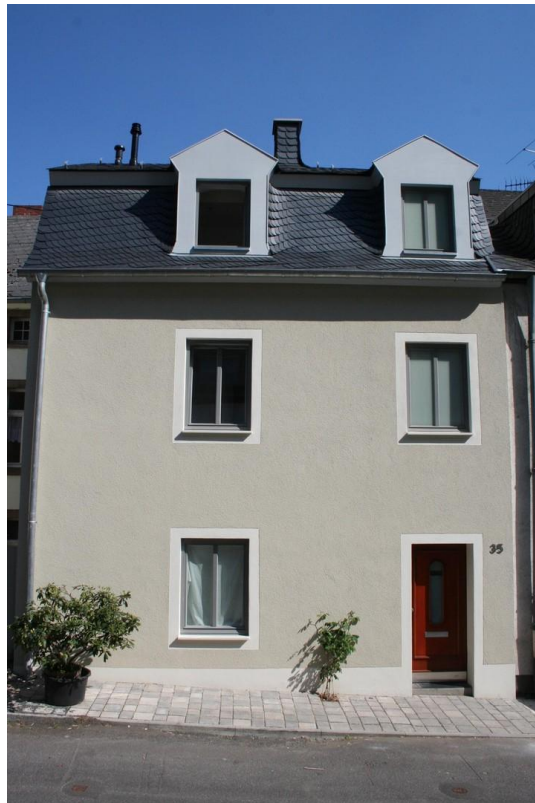
Fassade Palliener Straße
