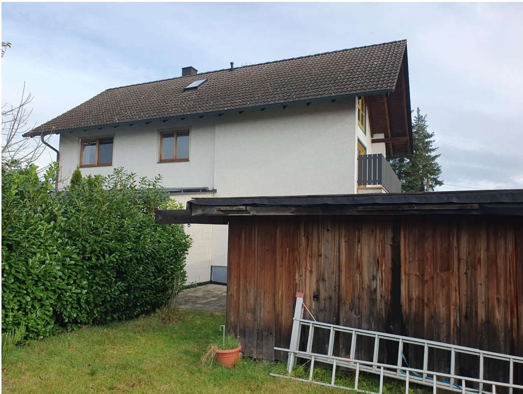
Carport/Haus vom Garten aus
