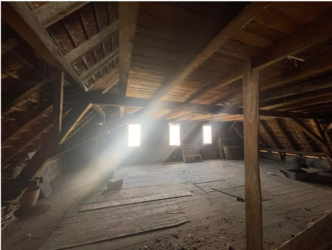
Dachstuhl Scheune 1. Etage
