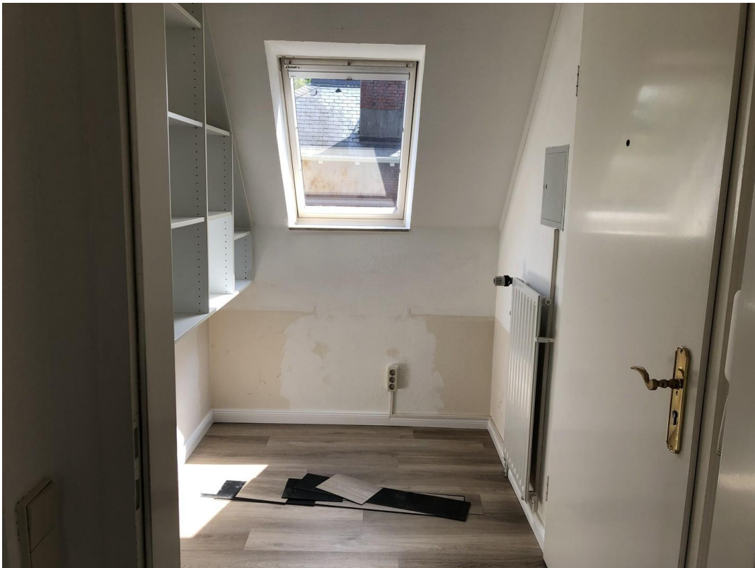
DG Flur (vor Malerarbeiten)
