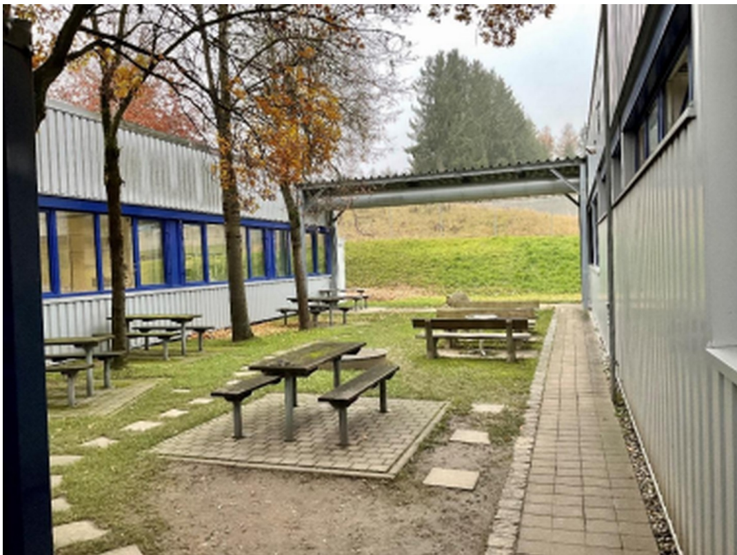
Begrünter Innenhof (Südwest)
