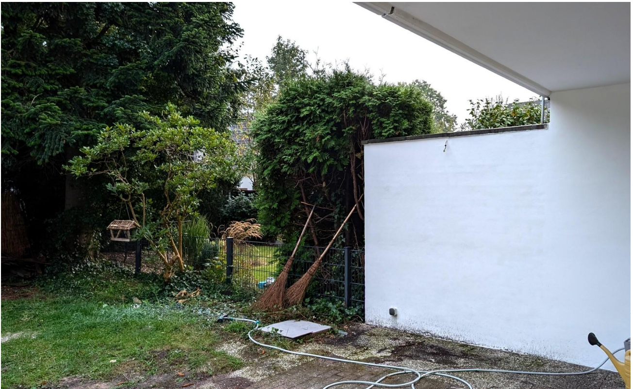
Neue Mauer rechts
