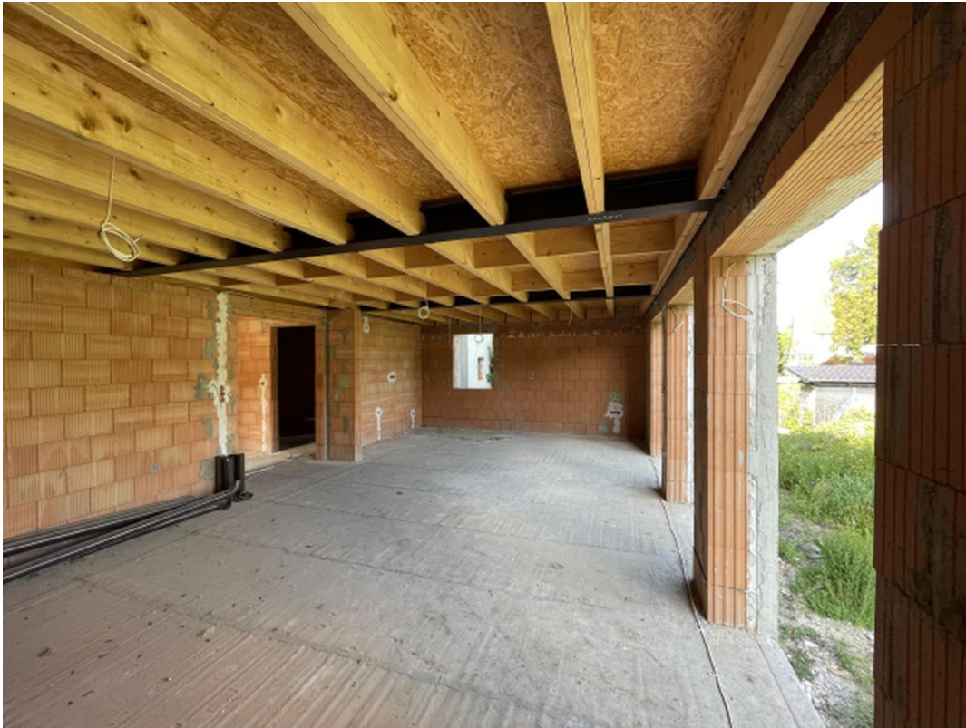
Innenansicht Rohbau I
