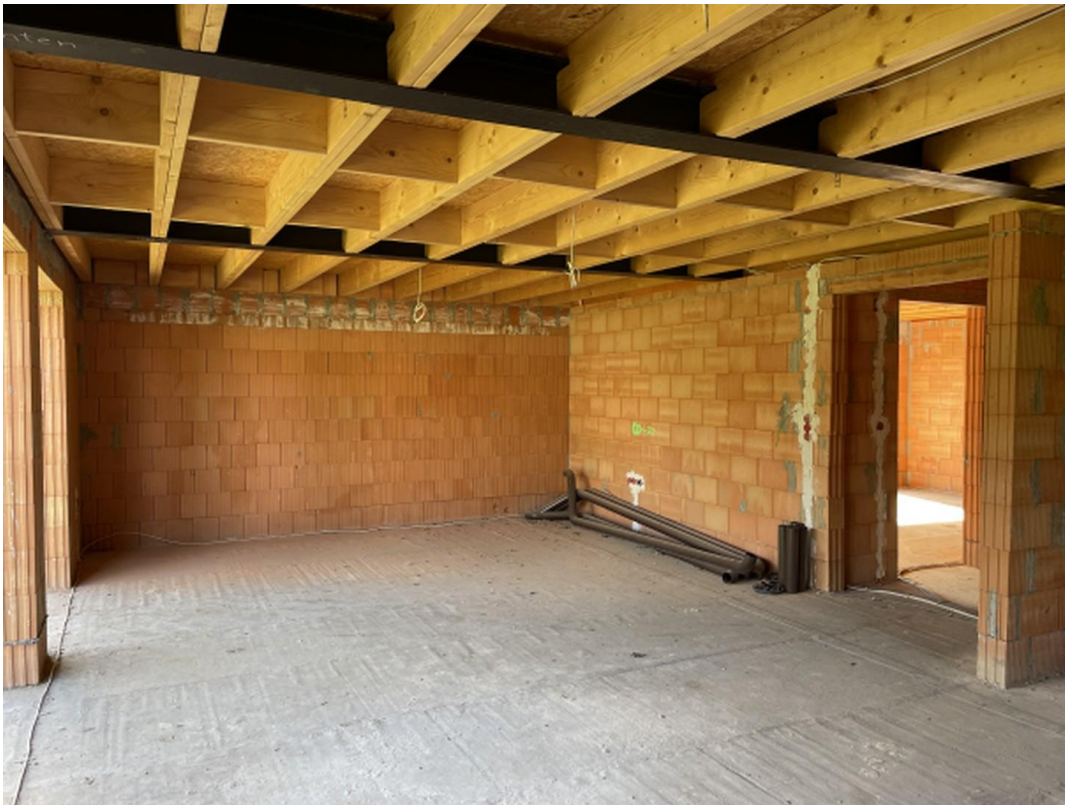
Innenansicht Rohbau III
