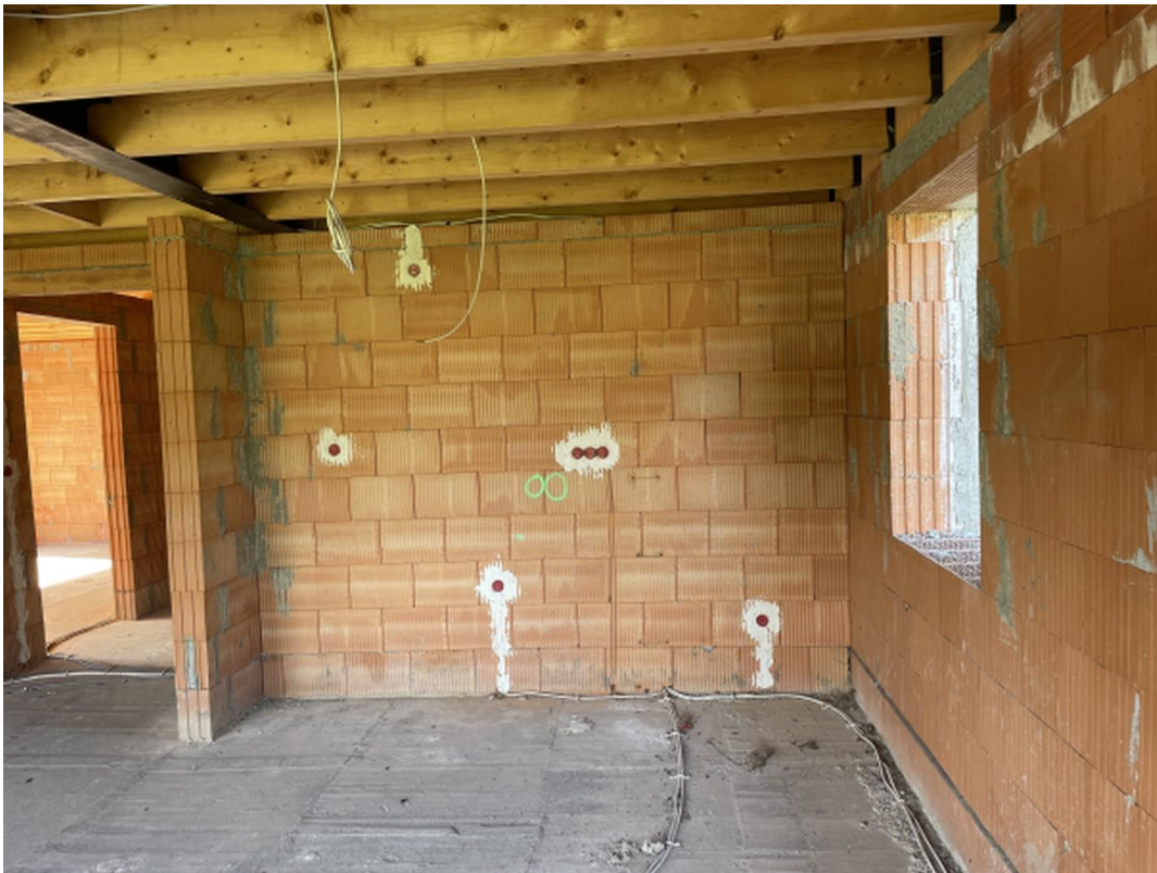
Innenansicht Rohbau II
