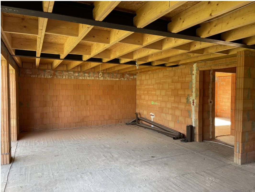
Innenansicht Rohbau III
