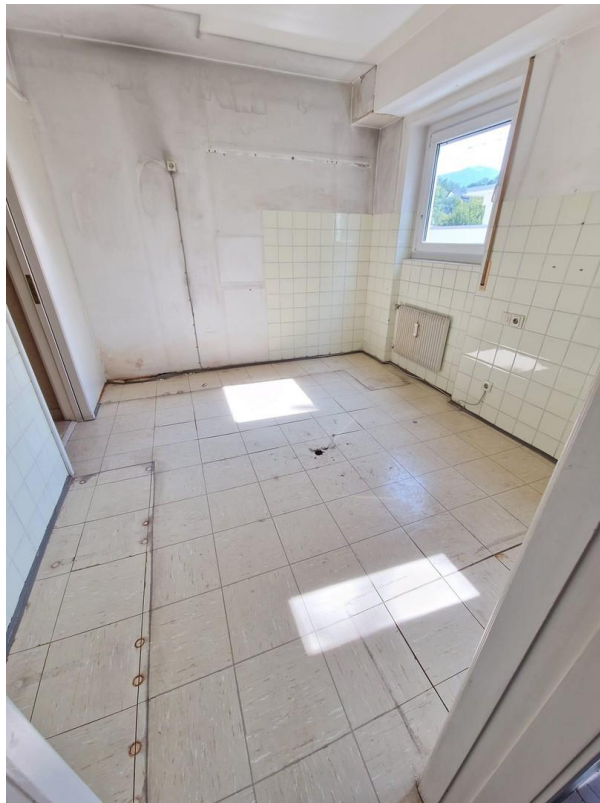
Küche wird saniert
