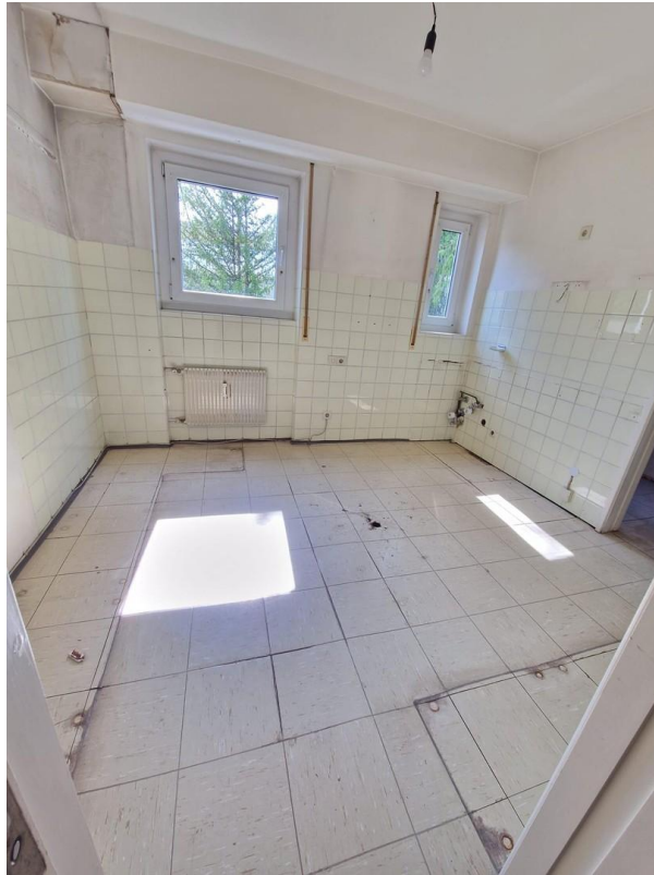
Küche, Boden und Fliesen neu
