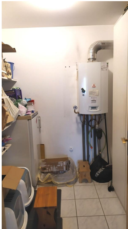
Abstellraum mit Heizung
