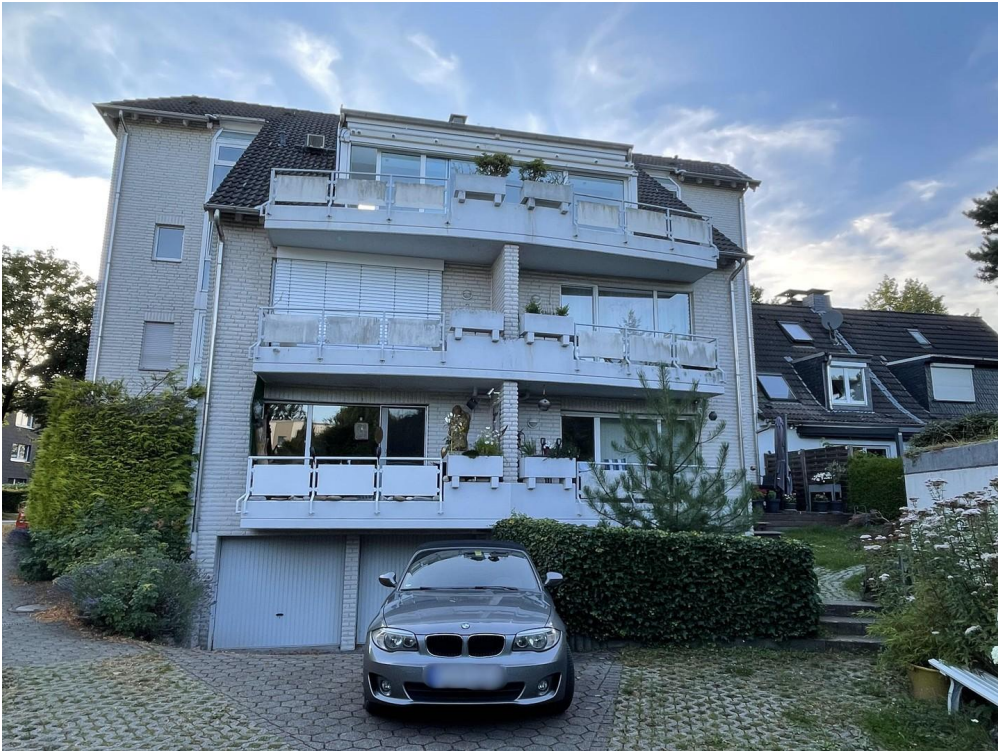
Rückansicht Haus & Garagen
