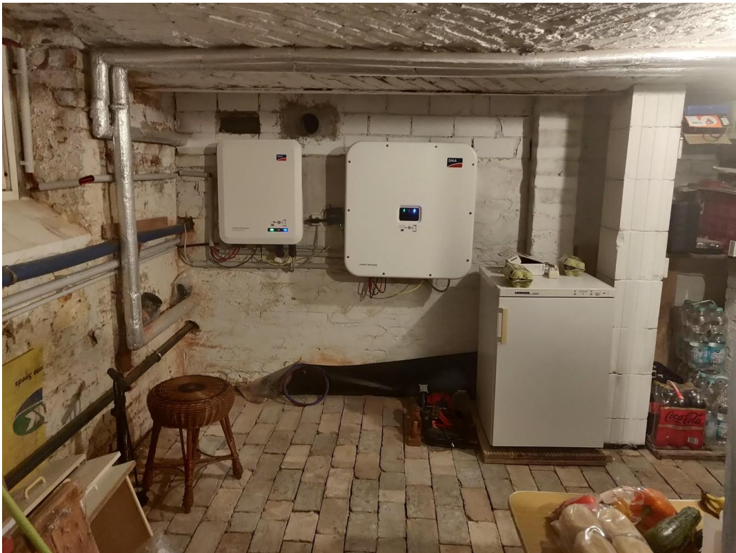
Wechselrichter
