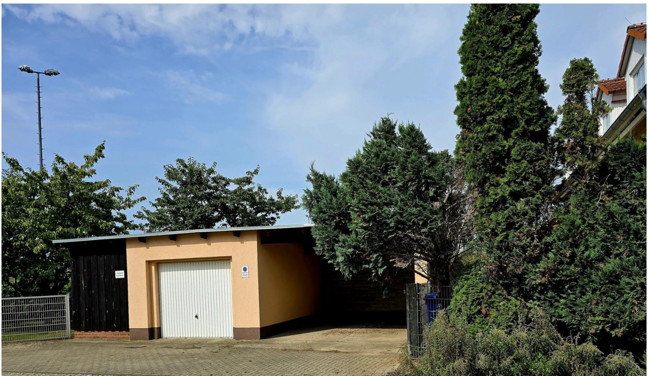
Garage mit Carport u. Schuppen
