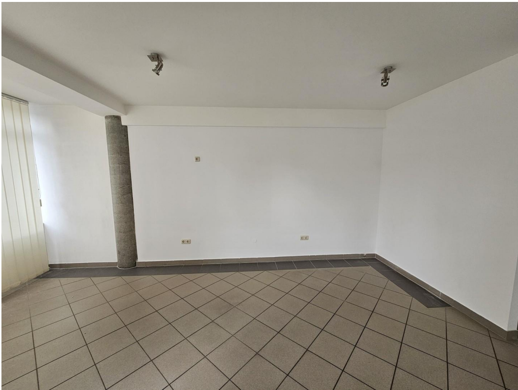
Büro- Blick in die Ecke
