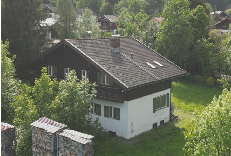
Abbildung 2 Wiesenweg12 Südost Ansicht
