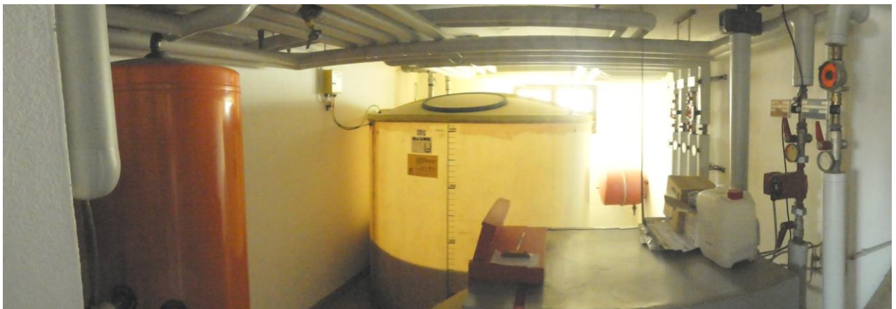
Abbildung 21 Heizraum mit Öltank
