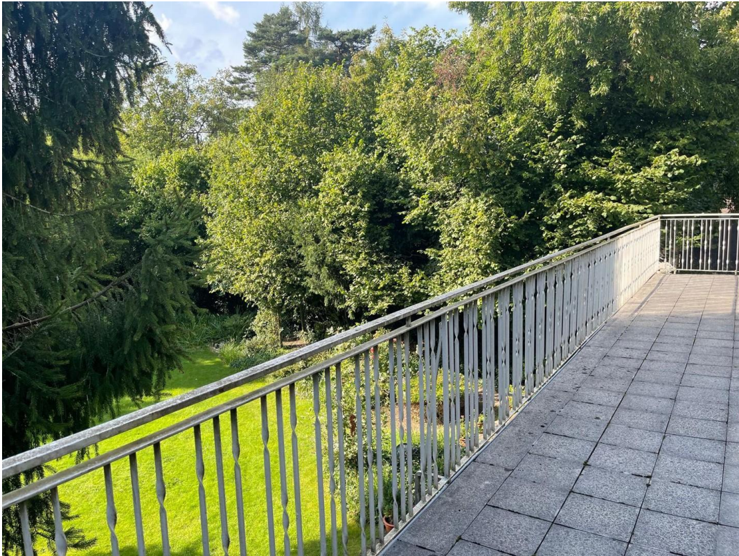
Balkon im OG
