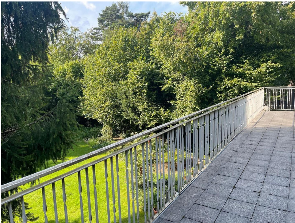
Balkon im OG
