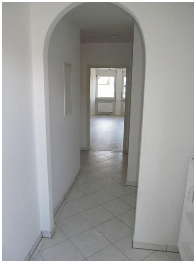
Vollverfliester Flur & Eingang
