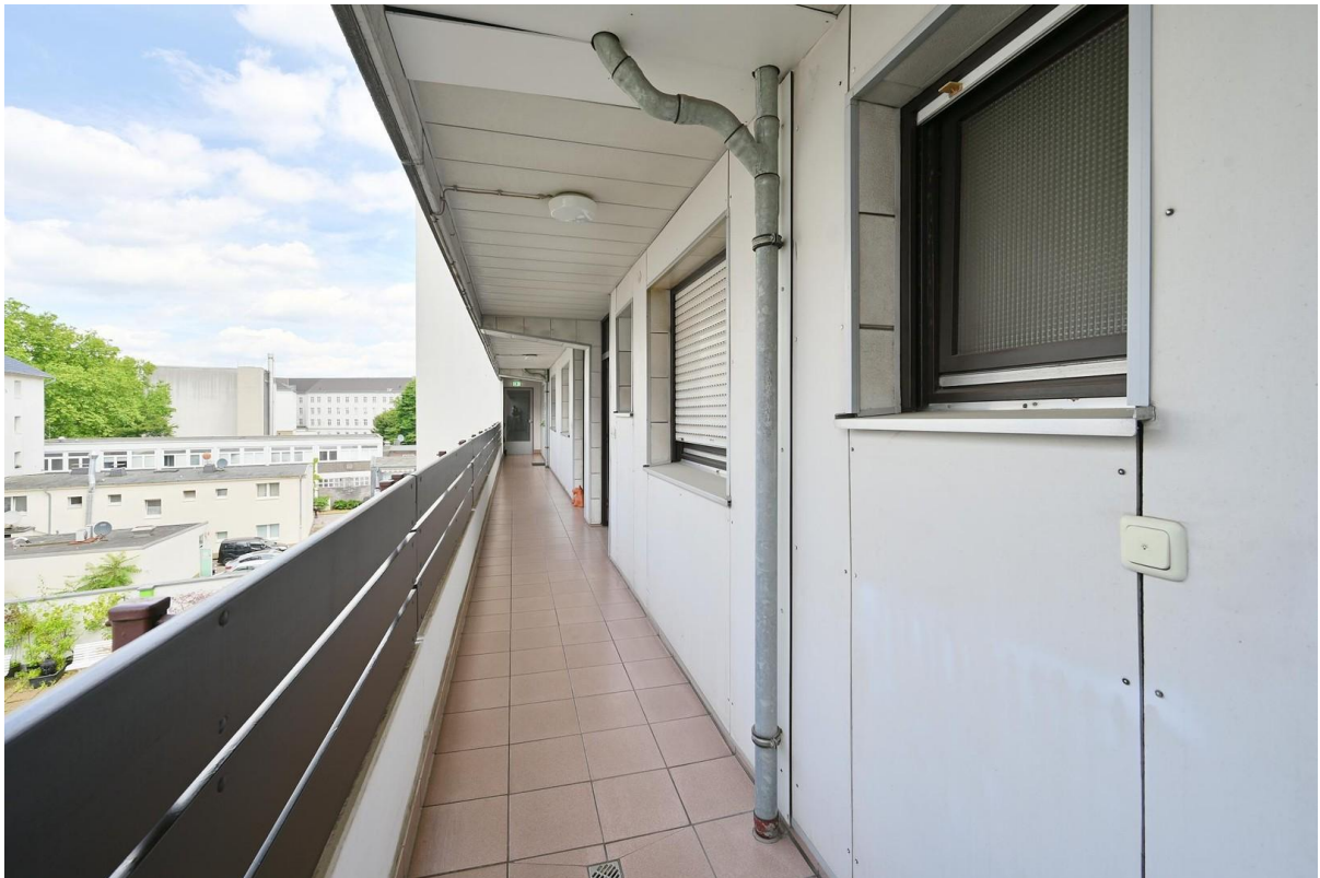
Laubengang zu den Wohnungen
