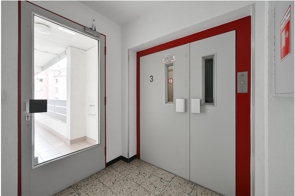
Aufzug zu den Wohnungen
