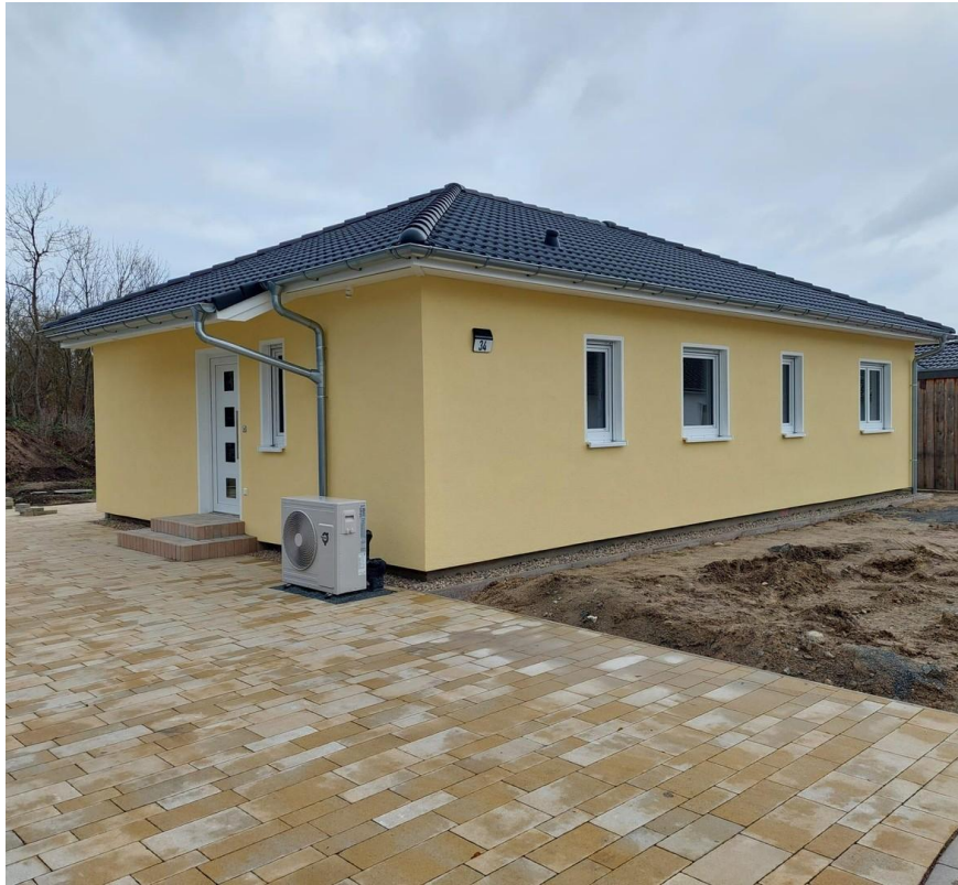
Frontansicht mit Eingang
