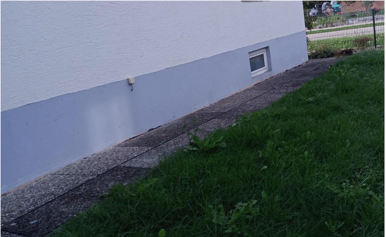
Seitl.Fassade, zum Boden hin
