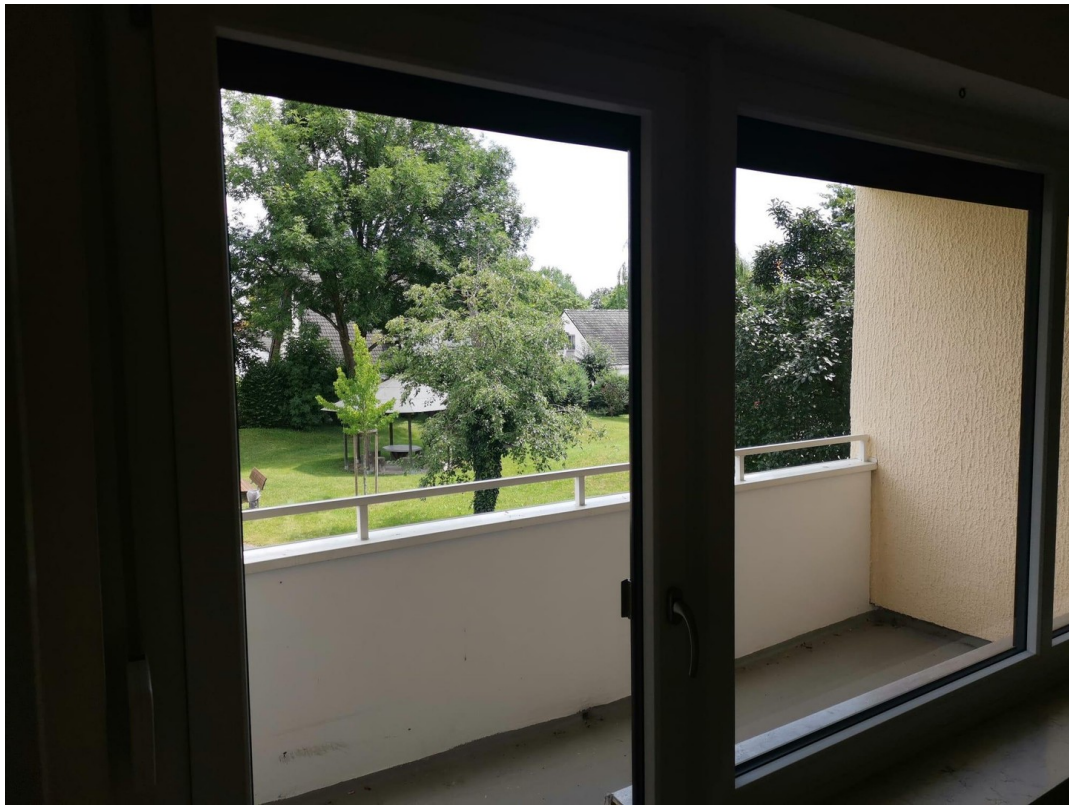
Balkon vor Sanierung
