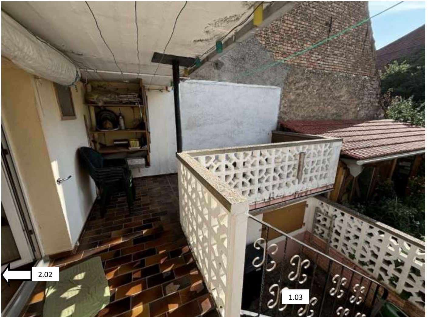
Übersichtsaufnahme Terrasse OG (Raum 2.04). Ein Teil der Terrasse ist vom Balkon des DG (Raum 3.03) überdacht. Links ist die geöffnete Tür mit Zugang zum Flug OG (Raum 2.02) erkennbar, rechts die Außentreppe in den Innenhof (Raum 1.03)
