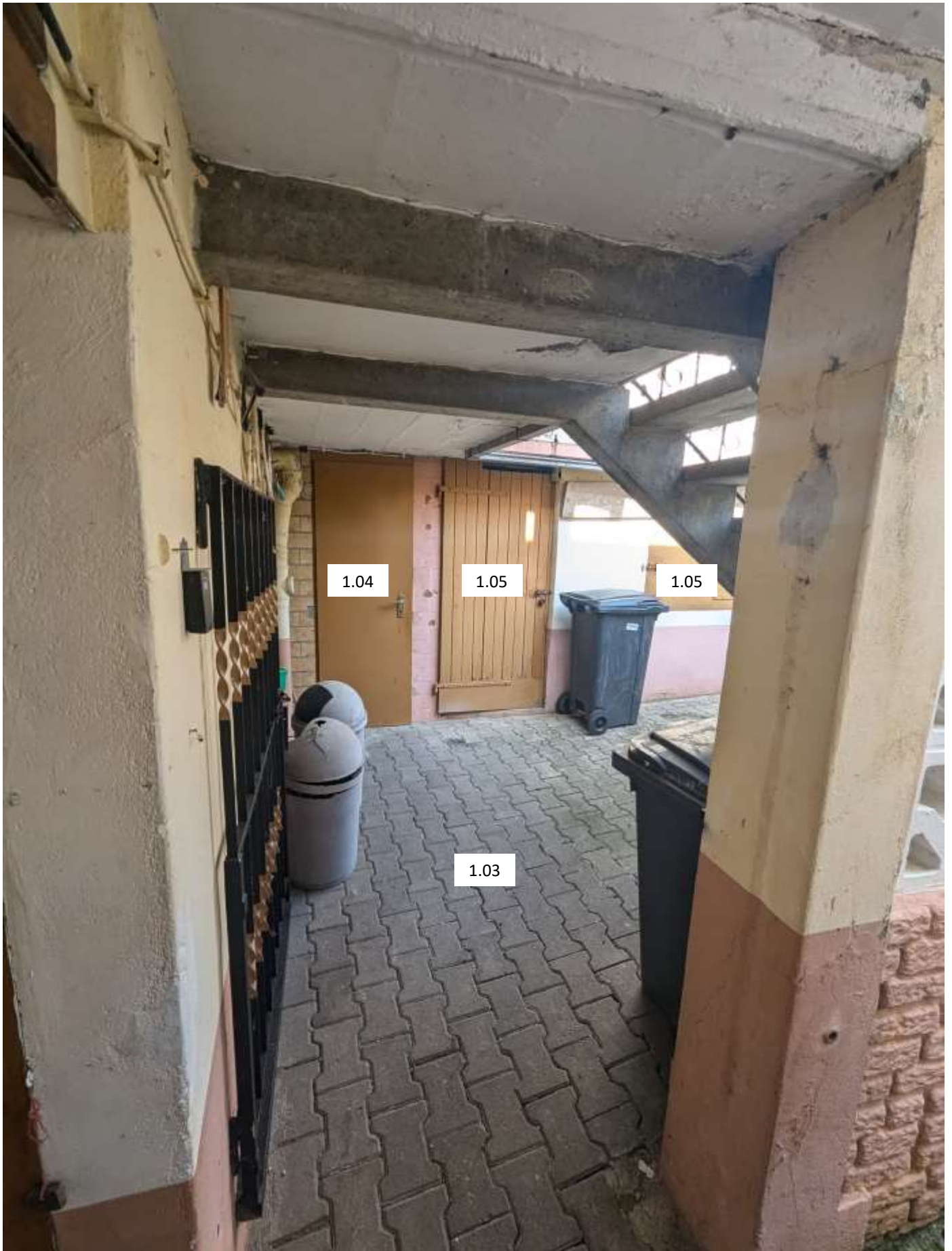
Zugang zum Innenhof (1.03) mit Zugangstüre zum WC (1.04) und zum Lager (1.05)
