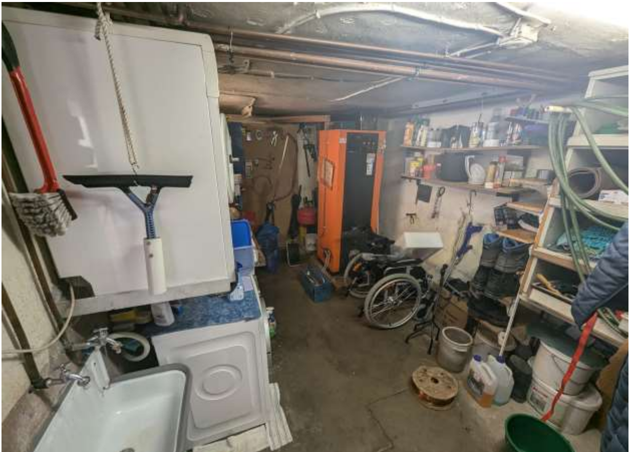
Detailaufnahme / Innenansicht Werkstatt bzw. Heizraum (Raum 1.07), Blick nach links
