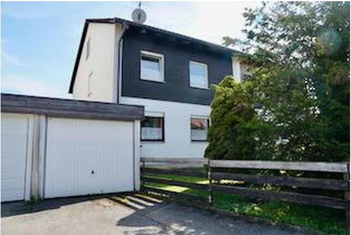
Ansicht mit Garage
