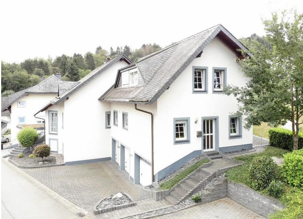
Anbau und Eingang Einliegerwhg
