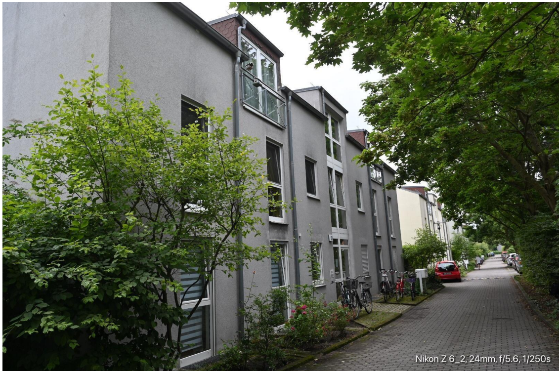
Blick in das Gebäude-Ensemble
