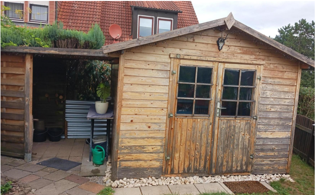
Gartenhaus mit Anbau
