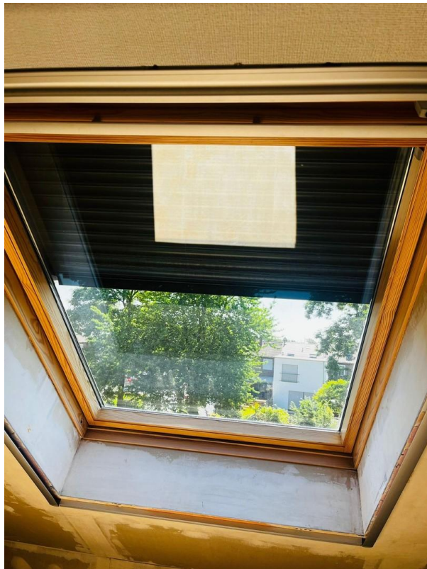
Fenster mit Außenrollos
