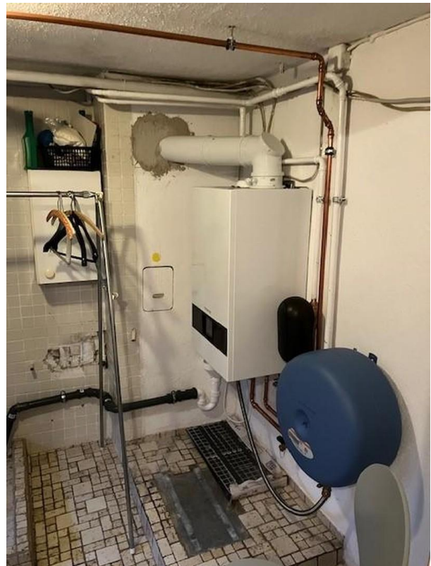
Heizungs- und Wäschekeller
