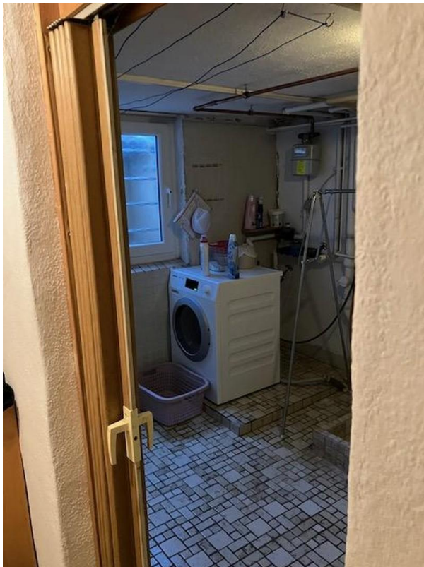
Heizungs- und Wäschekeller
