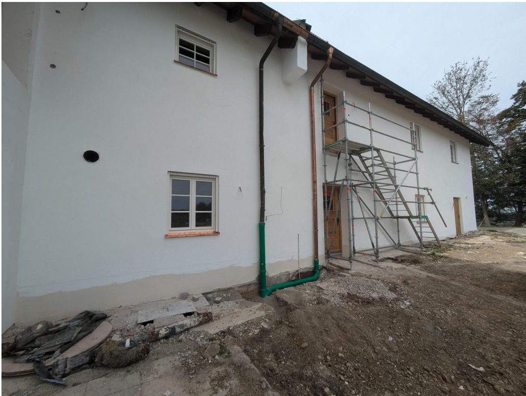
Eingangsbereich (im Bau)
