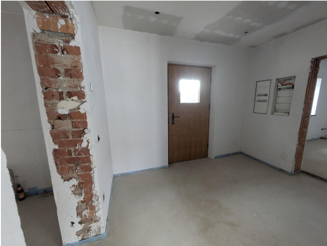
Eingangsbereich innen (im Bau)
