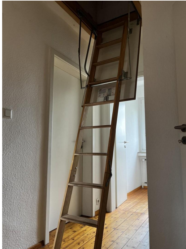
Aufgang zum Dachboden
