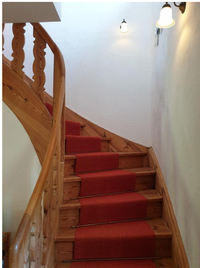
Treppe zur 1.OG
