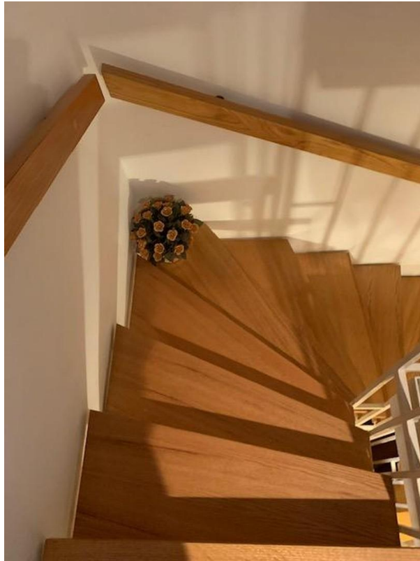
Treppenhaus mit Holzstufen
