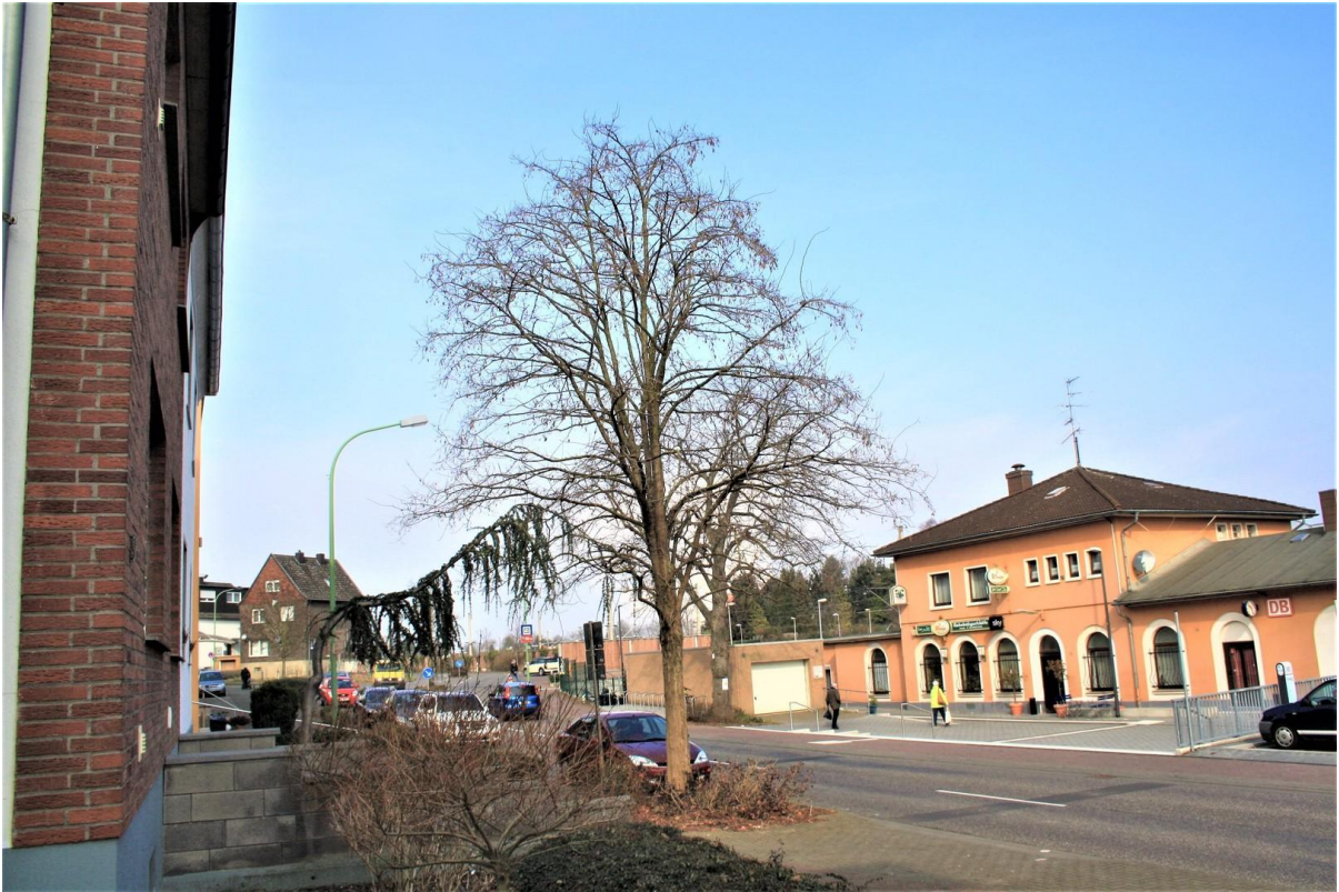
Gebäude mit Bahnhofsblick
