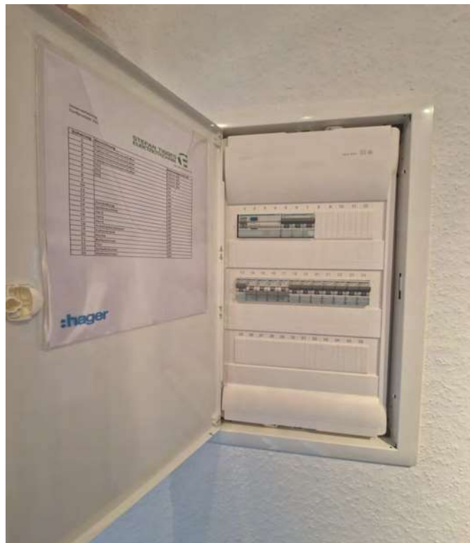
Stromverteilung in 3 von 4 WE neu
