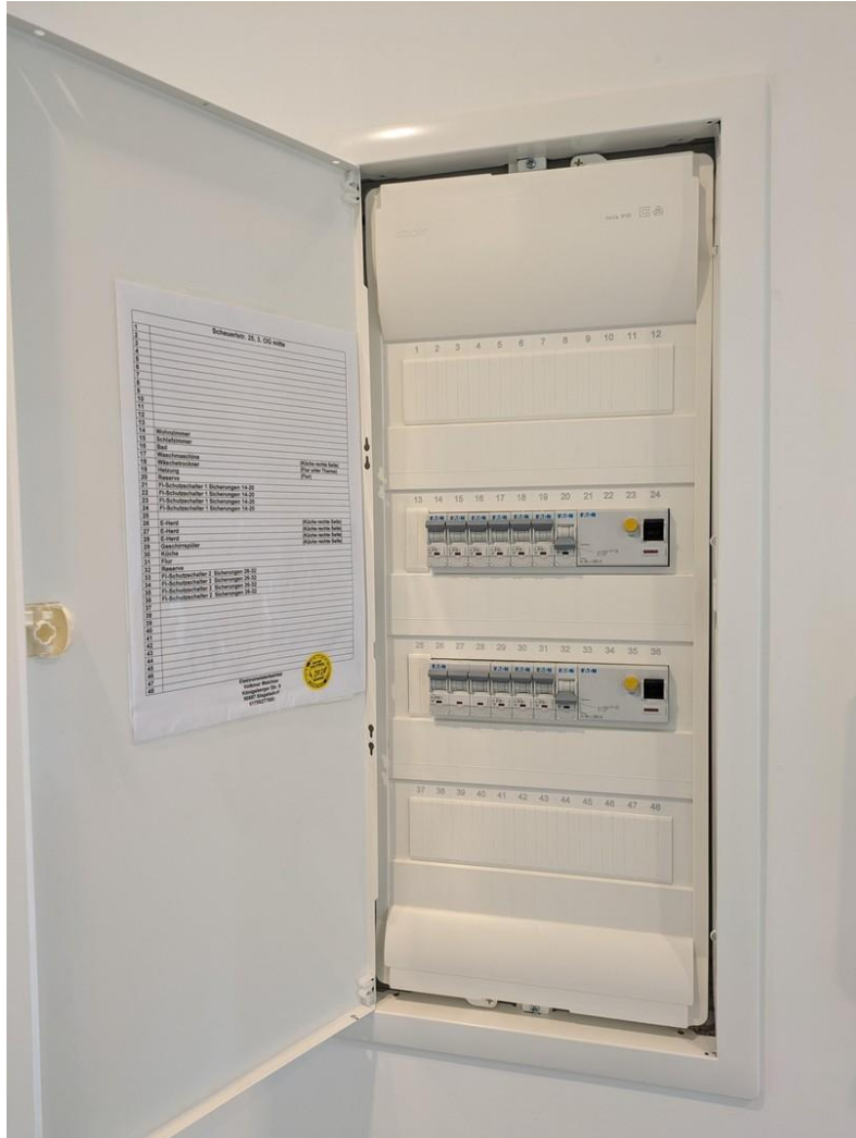
neuer Sicherungskasten
