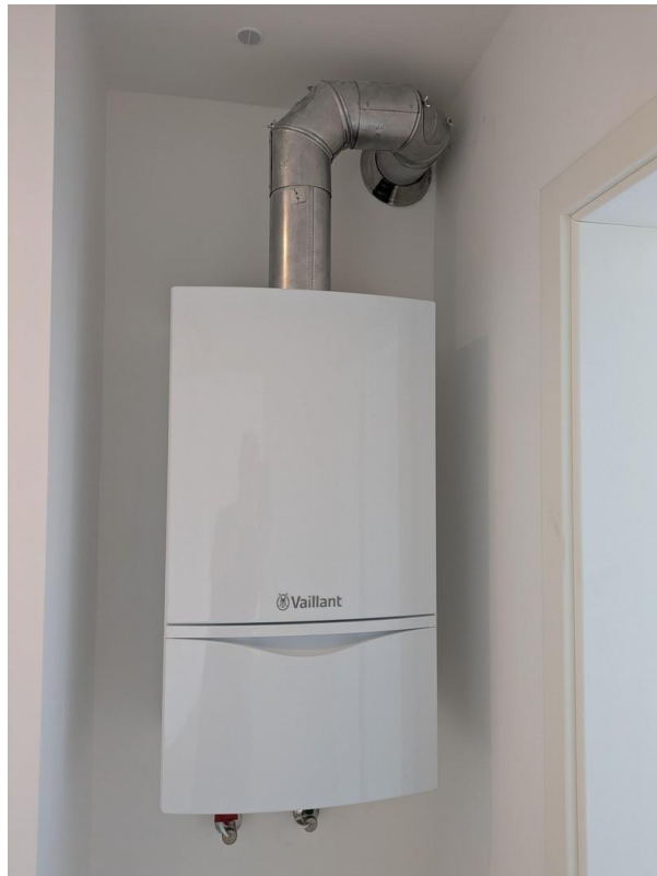
neue Gasetagenheizung
