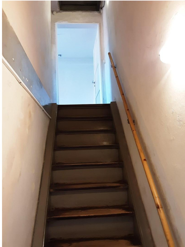
Treppe nach oben
