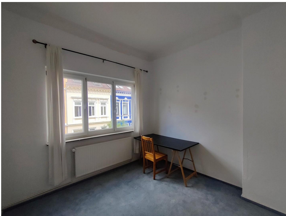
Zimmer nach Osten, 1. OG
