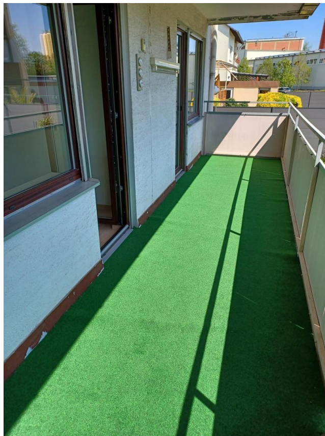
Balkon -wird gerade renoviert
