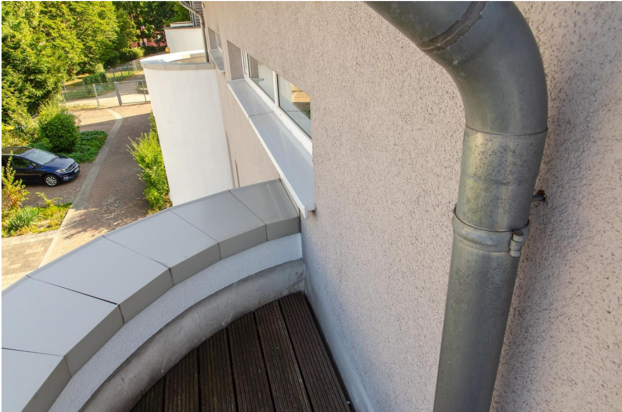
Detail der Dachbeplankung
