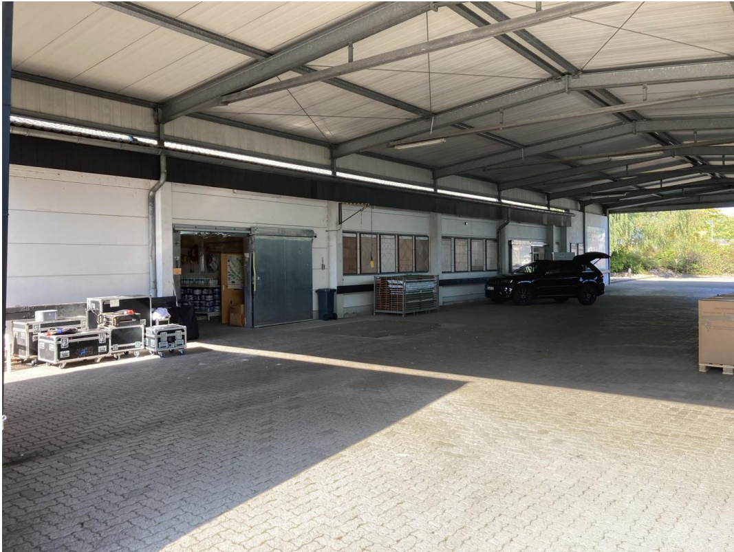
Be- und Entladung überdacht
