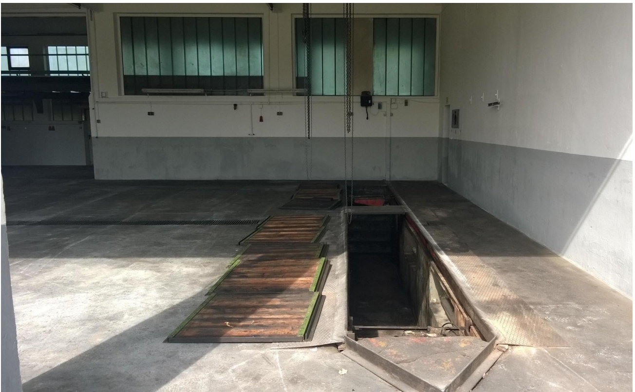
Begehbare Arbeitsgrube für LKW
